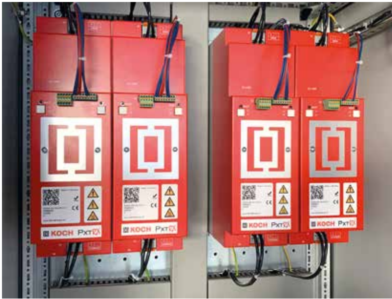
02 Vier „PxtRX“ parallelgeschaltet: So lässt sich die Leistung in der Spitze auf fast 200 kW erhöhen
