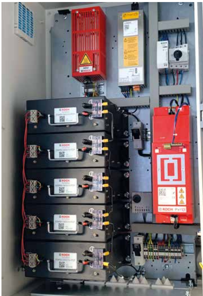
03 Beispiel für ein kleinen KTS-System: „PxtRX“ in Verbindung mit fünf Doppelschicht-Kondensatormodulen, einer sicheren Entladeeinheit und Notversorgung für ein DC-24-V-Netz sowie die passende anschlussfertige Absicherung und Verkabelung
